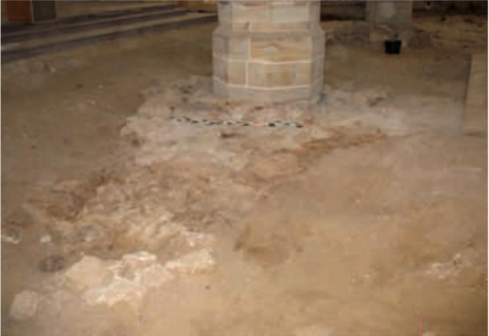
Abb. 4 und 5: Nord-Ost-Ecke der Kirche; Fundamentreste von älteren Kirchenbauten, unterschiedliche Steinsetzungen aus Findlingen und Raseneisenerzquadern, die Säule ist nach dem Zweiten Weltkrieg erneuert worden (Fotos: Sigrid Woehl)
